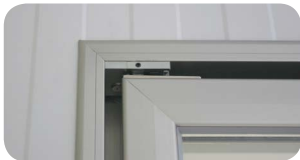
Fijación superior de la puerta con regulación
