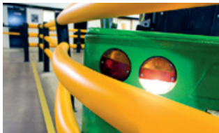
Menos daños a la barrera (reemplazos de postes y barreras)
